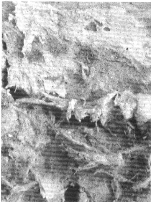
Fig. 8. Gulvbjælke med skruperevner, overflademycelium og myceliestreng.
