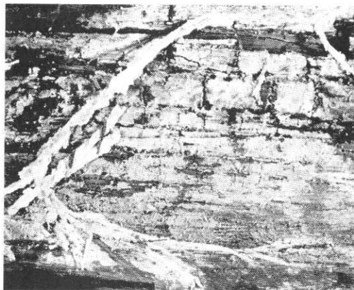
Fig. 54. Hvid Tømmersvamp ( Fibroporia vaillantii ). Overflademycelium og skrumperevner.
