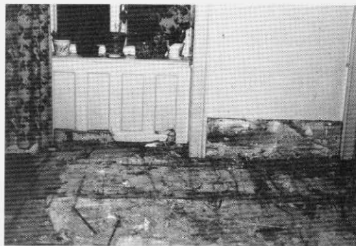
Fig. 5. Hussvampe-mycelium overvokser lerindskud. Ca. 3 m til fugtkilde.
