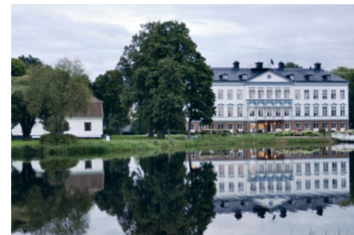
Folkehøjskoles hovedbygning. Foto Steen Elborne.
